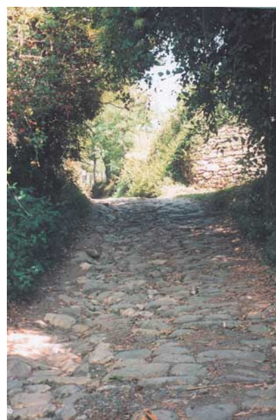
Esempio di lastricatura stradale, di media pendenza, del percorso francigeno nel territorio di Pontremoli.
